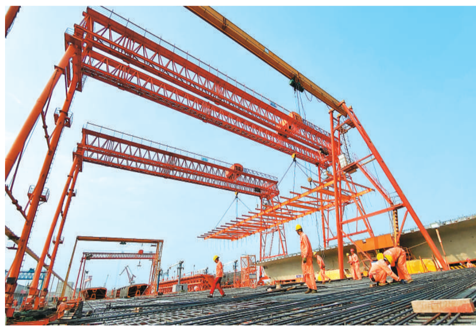
深(圳)中(山)通道是串联粤港澳大湾区、公路两网交通网的关键一环,建成后将成为连接珠江两岸的交通干线。图为深中通通道位于中山市一侧的建设现场。本报记者 金晨 摄
