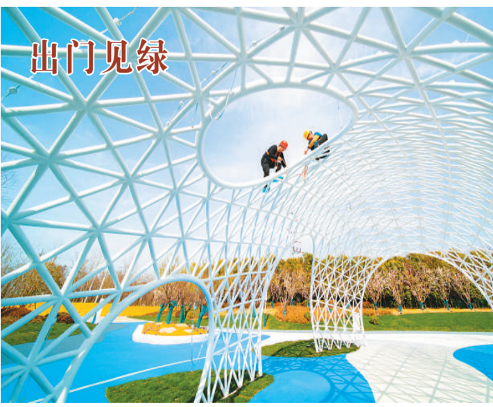
江苏省宿迁市扎实推进城市公园、绿地建设，打造了一批精品公园和街头绿地，形成水景交融、水木相依的滨水特色。图为3月24日，工人在酒都文化公园装饰廊道进行亮化施工。 陆启辉摄（人民视觉）
