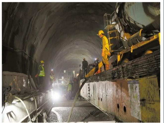
汕頭鐵路礦山法隧道裏，施工人員正在灌注混凝土。
