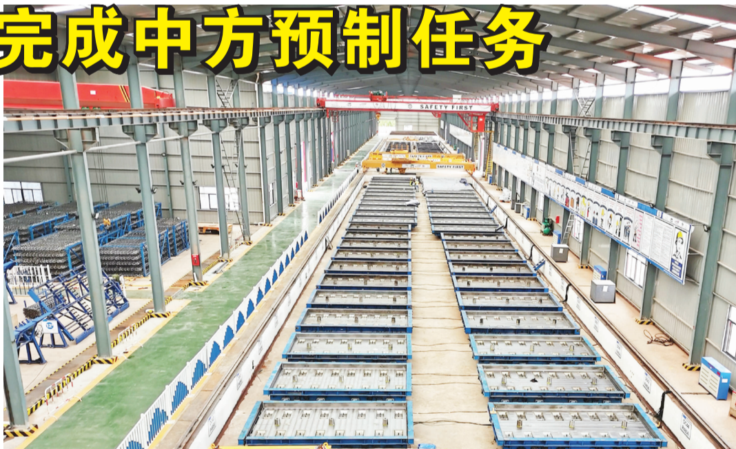
雅万高铁轨道板厂生产车间
