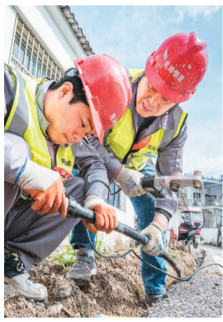
安徽省芜湖市繁昌镇范家村东风村民组，供水施工人员进行农村供水改造作业。 肖本祥摄（人民图片）
