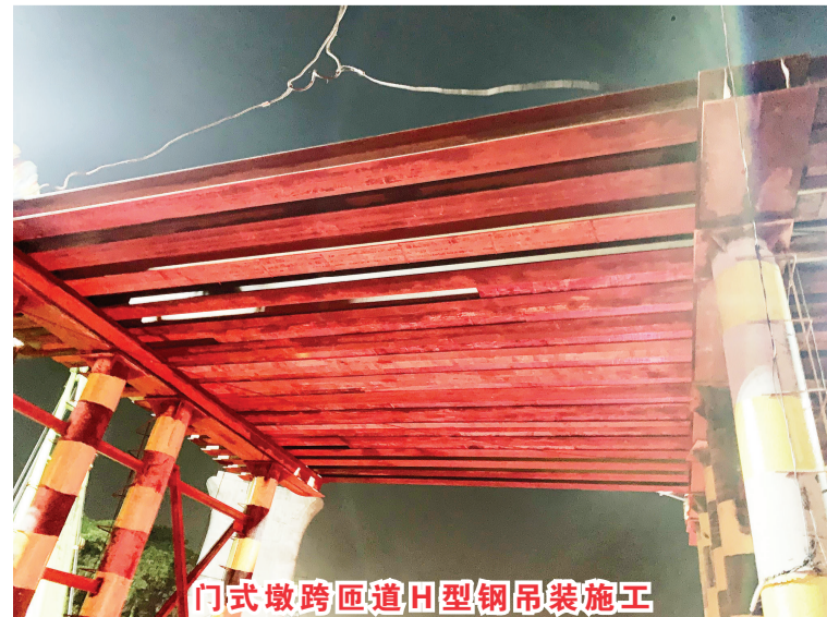
门式墩跨匝道H型钢吊装施工
