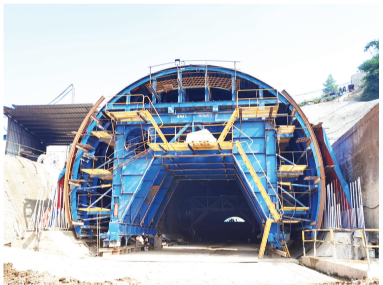
新增隧道洞口台车形象图
