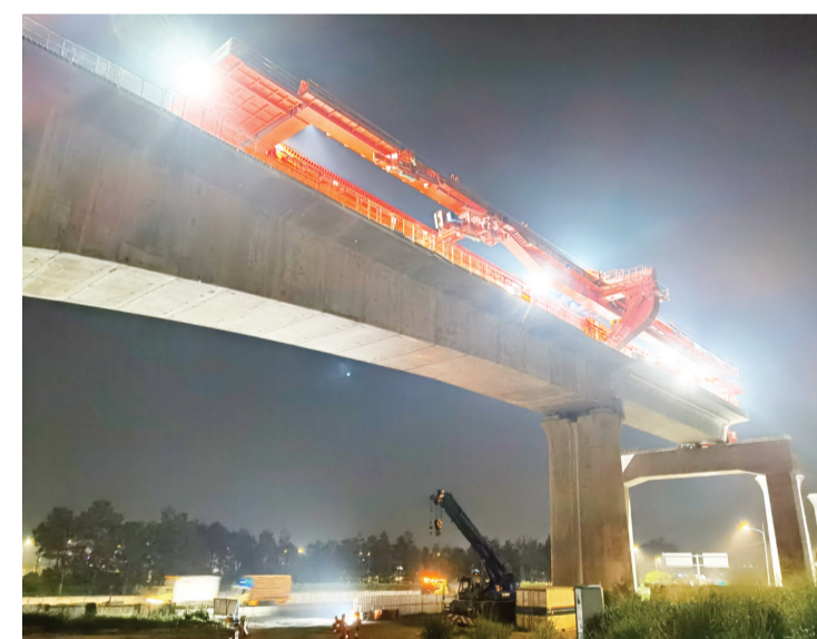
跨路箱梁架设完成
