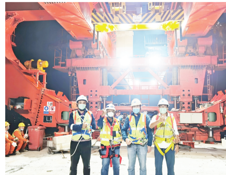
雅万高铁监理联合体CDJO副总监Suryanto现场观摩架梁
