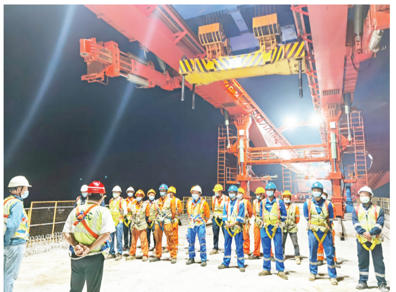
箱梁架设班前安全教育
