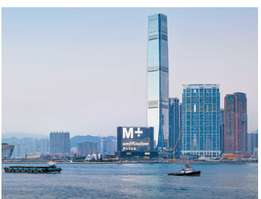
從維多利亞港望向M+大樓。(Herzog & de Meuron提供圖片)
