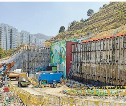
沙田污水廠搬遷第一階段工程主要於岩洞入口處開拓工地及興建主連接隧道。
