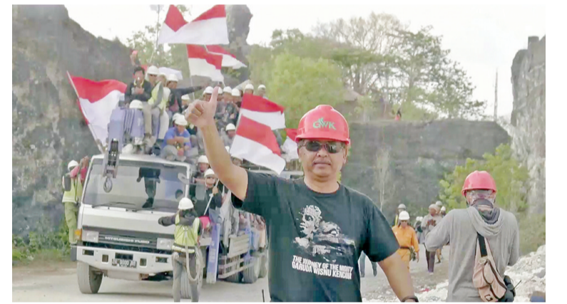
努阿塔先生在施工现场指挥
