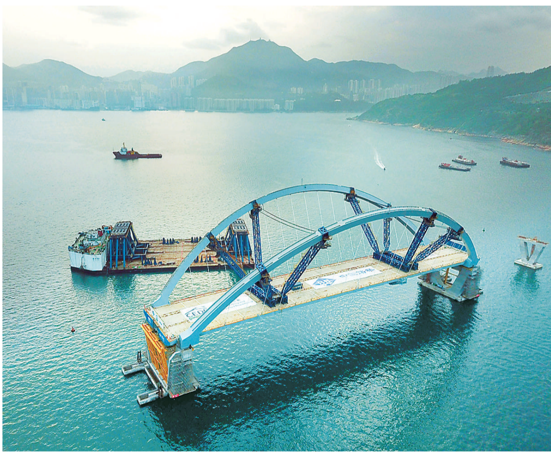
由内地企业独家承建的香港将军澳大桥主桥近日成功安装，这一外飘式双拱钢桥重约1万吨，以高强度钢材建造，跨径200米，建成后将是全港跨度最大和单体最重的钢拱桥，将成为香港又一地标性跨海建筑。
