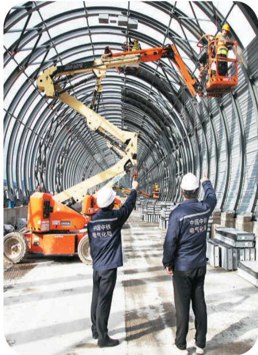
▲2月27日,在杭绍台城际铁路浙江省台州市路桥区桐屿街道路段,中铁电气化局的建设者正在轨道线上安装隔音设施。 蒋友青摄(人民视觉)
