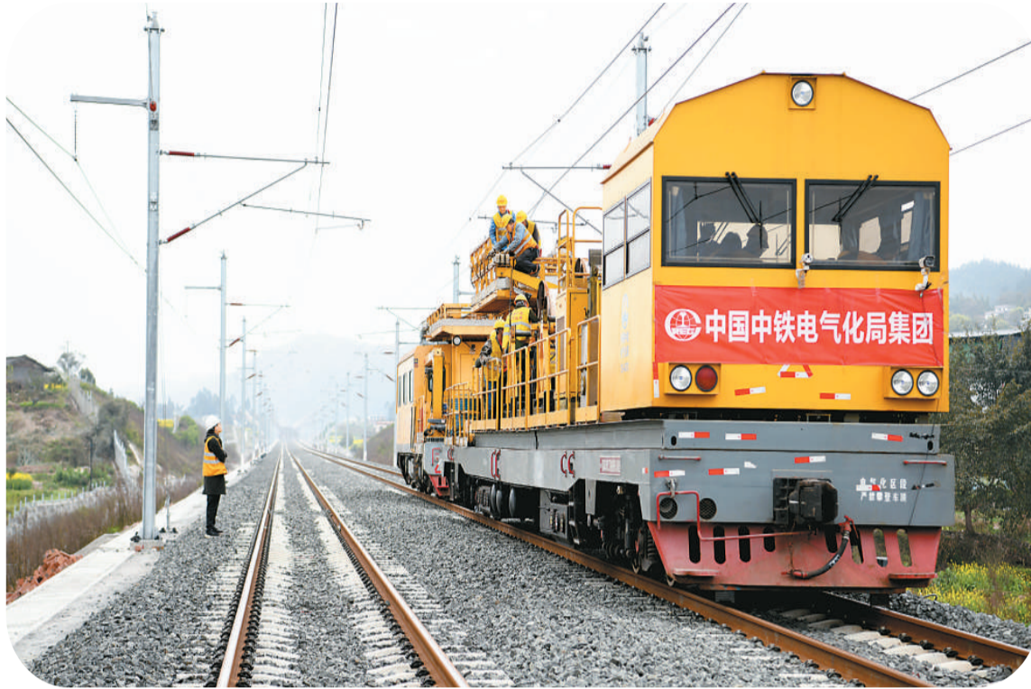
▲近日,为确保川南城际铁路新线建设有序推进,中国铁路成都局集团有限公司全过程参与施工各环节,为川南城际铁路接管后的安全运营工作打下坚实基础。图为2月25日,公司职工正在盯控接触网架线施工。 胡志强摄(人民视觉)
