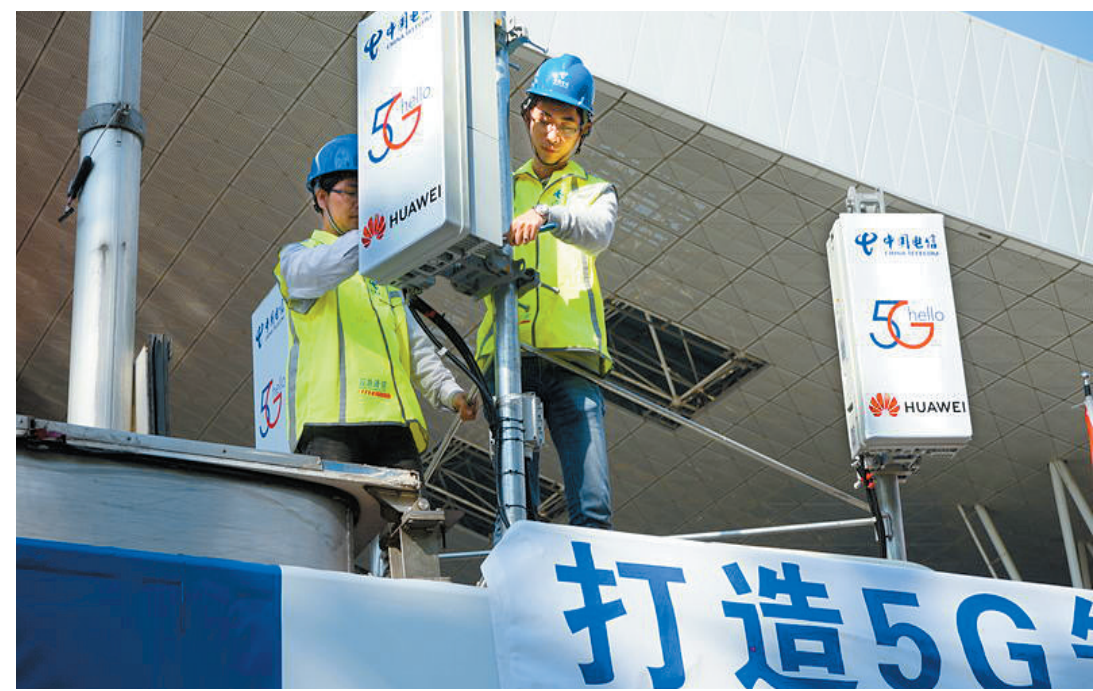
圖為電信技術人員進行5G基站設備的建設和維護工作。資料圖
