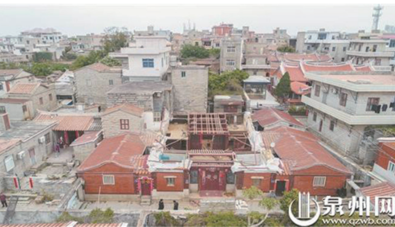
▲林廣記正在修繕中
