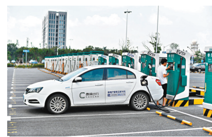
● 多地相繼出台建充電樁等政策支持新能源車發展。
