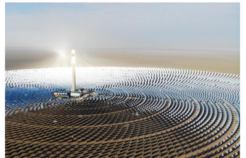
2月24日拍摄的敦煌100兆瓦熔盐塔式光热电站(无人机照片)
