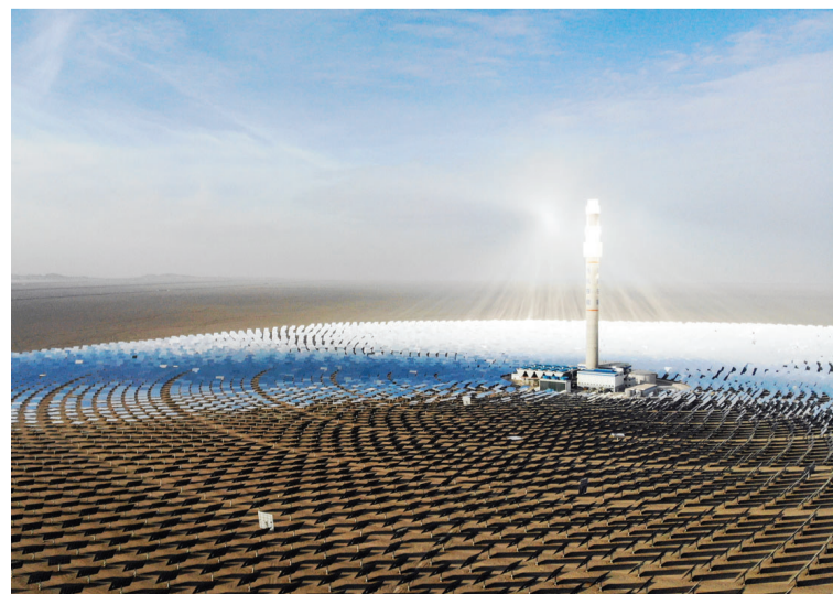
2月24日拍摄的敦煌100兆瓦熔盐塔式光热电站(无人机照片)
