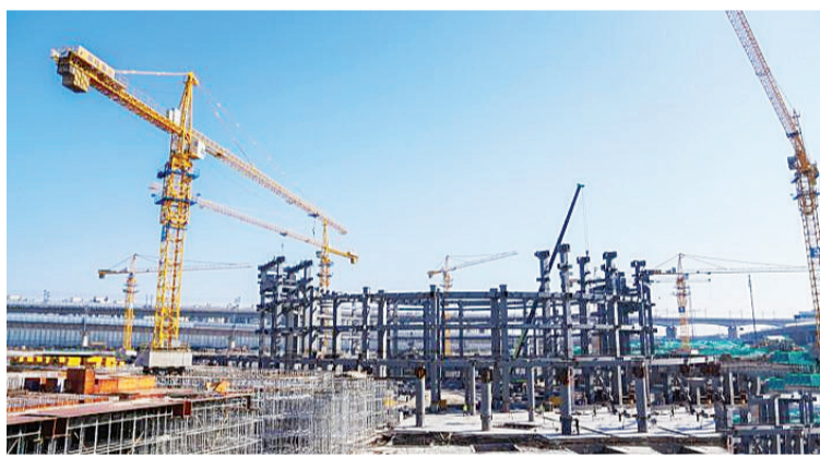
施工中的下城区电竞场馆。下城区融媒体中心供图
