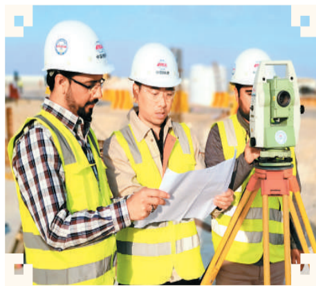
图为中铁十八局集团沙特分公司萨拉曼国王能源城项目公司代表李义民(左二)和外籍技术人员在研究施工方案。
