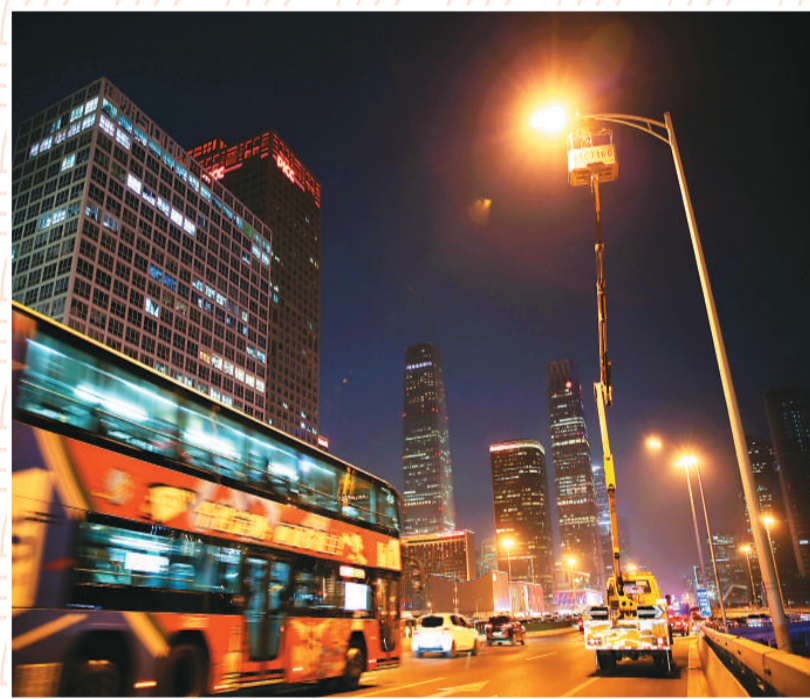
▲ 春节期间,国网北京电力城市照明管理中心加强对重点道路、地区的照明保障和值守工作,为首都市民度过一个欢乐祥和的春节营造良好的氛围。图为该中心工人正在维修北京三环路上的高杆路灯。 本报记者 贺勇摄
