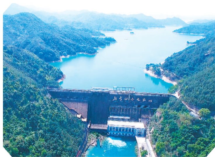
▲ 东深供水工程水源水库——广东河源新丰江水库。(资料图片)
