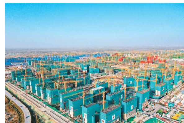
图为河北雄安新区容东片区安置房项目建设现场。 新华社记者 牟宇摄
