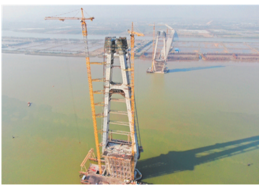
▲近日，中開高速建設迎來新進展，銀洲湖特大橋東岸索塔順利封頂。
