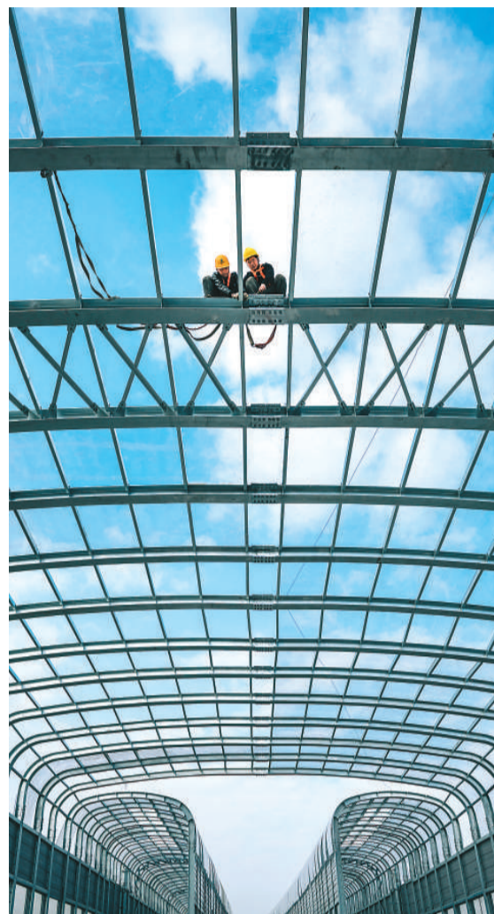
近日,位于广东省佛山市顺德区陈村镇的佛山地铁2号线石洲站的施工现场,铁路建设者正加快推进铁路隧道隔音屏安装。佛山地铁2号线是佛山地铁第二条线路、贯穿佛山东西向的骨干线,计划今年开通运行。 邱新生摄(人民视觉)
