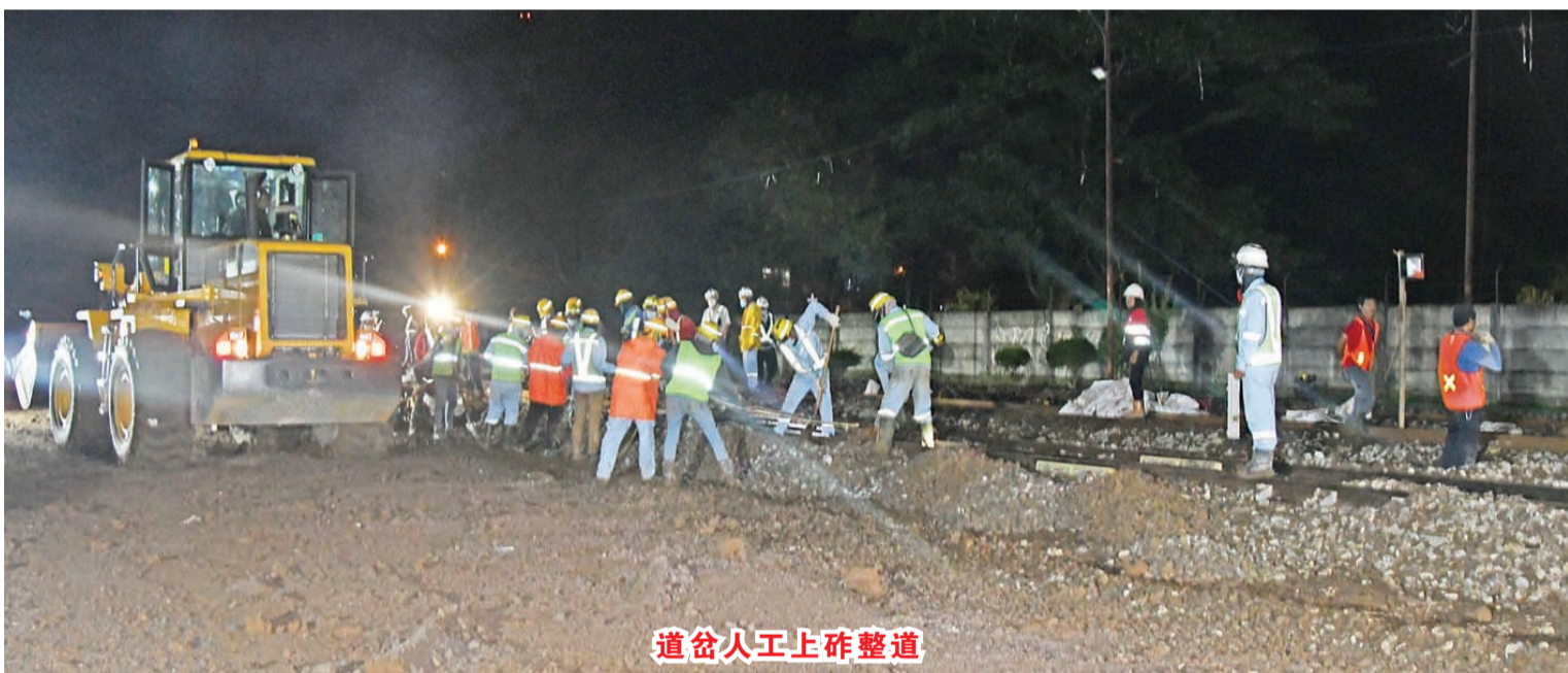
兰泽可站道岔插入施工
