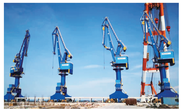
松下港12号、13号泊位局部。(松下码头有限公司供图)
