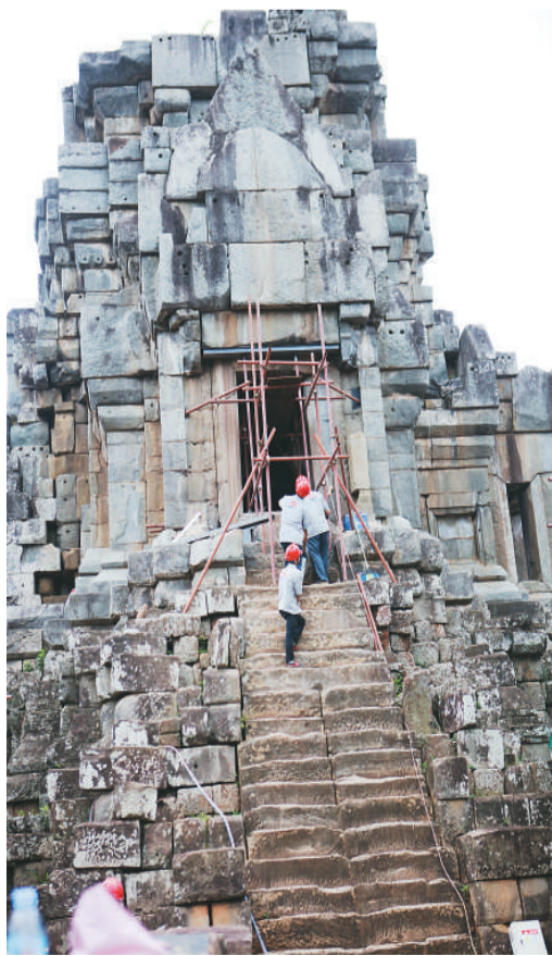
左图：中国工作队对茶胶寺中央主塔抱厦入口进行钢结构支护。由于大型机械设备不能登上须弥台，工人们需要自己搬运钢材。每一个钢结构支护框都是根据石头的残损状况现场制作，通过这种“量体裁衣”的方式确保对石构件不造成任何伤害。（记录于2016年）
