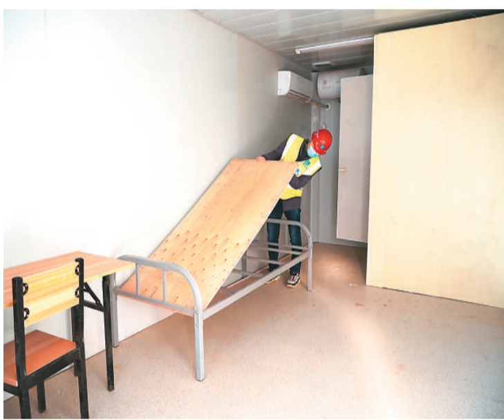
图为1月19日，工人在石家庄黄庄公寓集中隔离场所工地准备交付的房屋内安装床铺。 新华社记者 杨世尧摄
