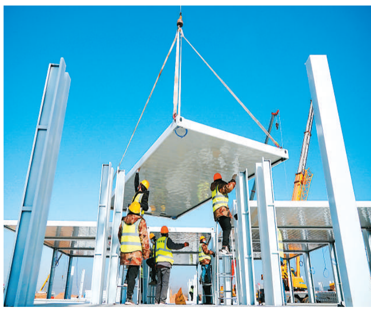
图为1月18日，工人在石家庄市黄庄公寓隔离场所项目工地安装集成房屋。 新华社记者 杨世尧摄
