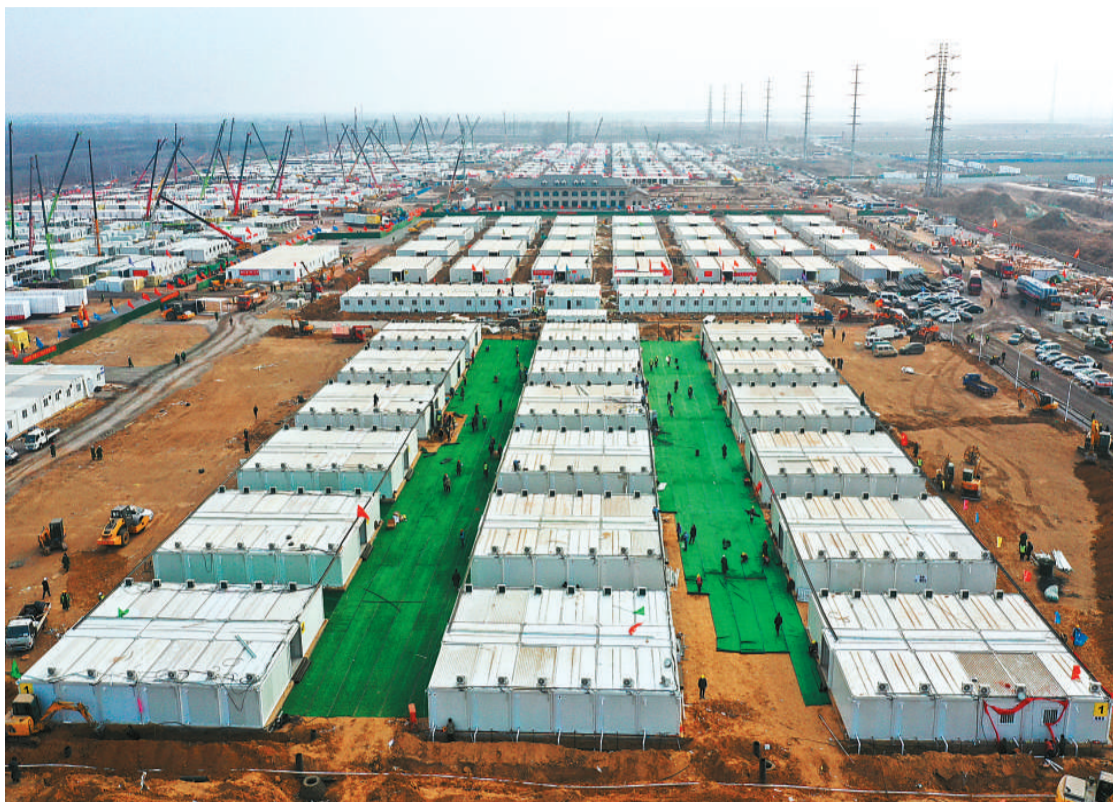
1月19日，石家庄黄庄公寓集中隔离场所有606套隔离房和配套设施交付，接下来将再交付1173套。其它工程也在抓紧往前赶。项目选址在正定和藁城交界的黄庄村南，实际占地658亩，建筑规模从初期的3000套增加到4156套。图为工人在工地整理准备交付房屋地面。 新华社记者 杨世尧摄
