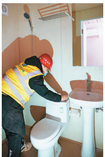
图为1月19日，工人在石家庄黄庄公寓集中隔离场所工地准备交付的房屋内进行整理。 新华社记者 杨世尧摄
