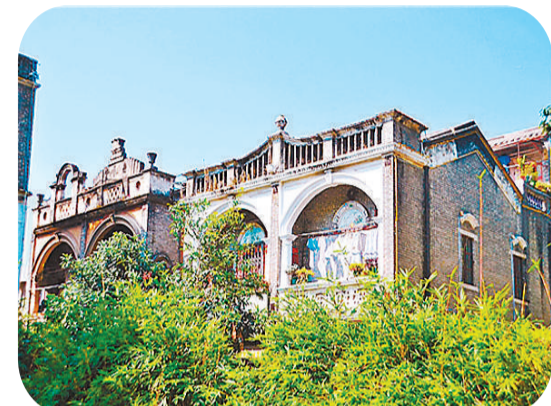
位于广东省江门市蓬江区白沙街道的历史街区建筑。(资料图片)
