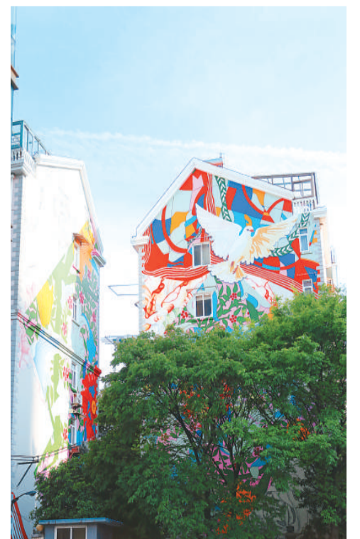
位于上海市天山路的小区住宅。 陈宇宇摄（人民视觉）
