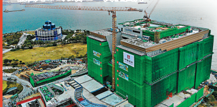
香港故宮文化博物館大樓結構去年11月竣工。資料圖片
