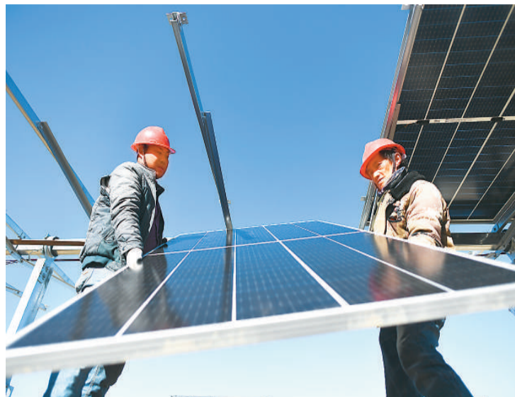
日前，在位于青海省共和县的大唐集团三十万千瓦光伏项目现场，工人正在进行安装。新华社记者 张宏祥摄
