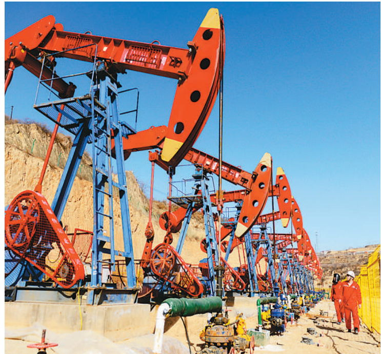
近期,位于山西省临汾市的中国石化华东石油局延川南煤层气回克服极端严寒天气,在抓好新井投产的同时,统筹老井生产和集输运行,冬季生产安全平稳。图为1月14日,延川南煤层气回克职工在生产平台巡回检查。 沈志军摄(人民视觉)
