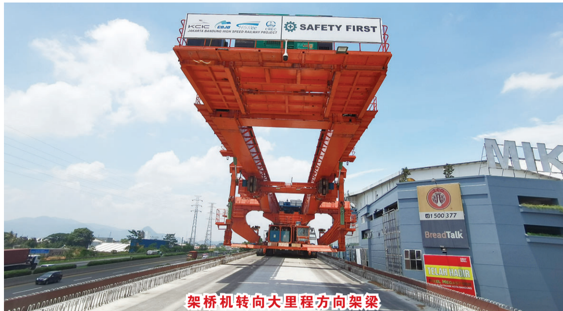
架桥机转向大里程方向架梁
