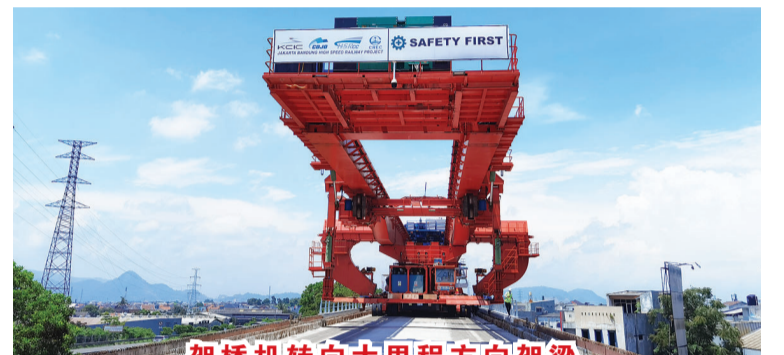
架桥机转向大里程方向架梁
