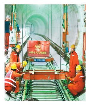
日前,位于湖南省长沙市的中铁电气化局韶光站地 铁铺轨基地,两台大型轮轨式龙门吊将长达25米的轨排 轻轻抓起, 稳稳地落在轨道地下线。图为工人正在进行 铺轨作业。
