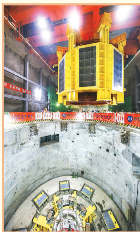
浙江安吉县长龙山抽水蓄能电站首台机组定于吊装到位。潘学康摄（人民图片）
