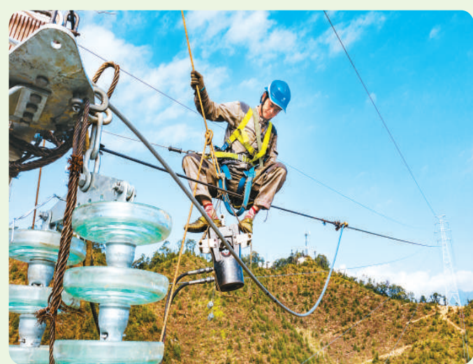
安徽送变电工程有限公司施工人员在安徽省黄山市祁门县的山区加紧建设输电工程。郑贤列摄（人民图片）
