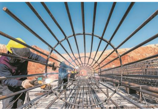
工人正抓緊施工
