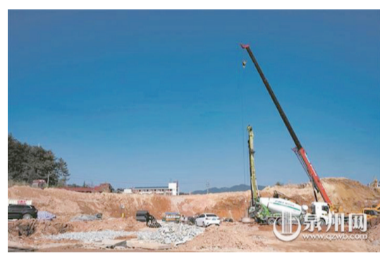
陶瓷會展中心施工現場
