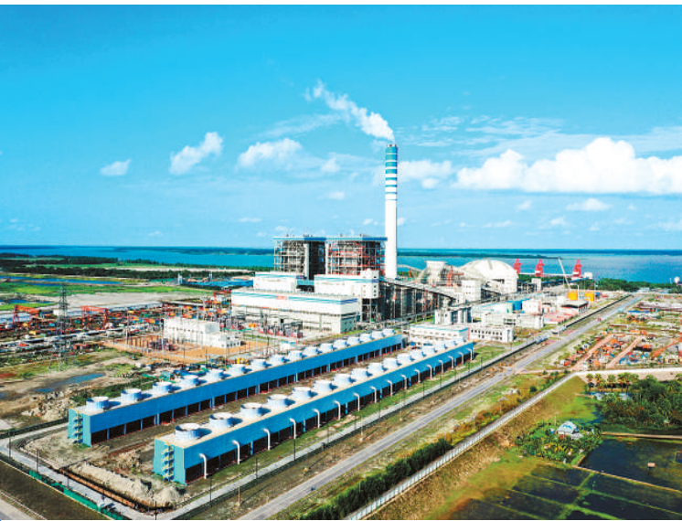
中国通用技术集团所属中国机械进出口(集团)有限公司(以下简称“中机公司”)参与投资的孟加拉国首个超临界燃煤电站日前全面进入商业运营阶段。帕亚拉2×660兆瓦超临界燃煤电站位于孟加拉国南部博杜阿卡利县,是“一带一路”沿线重点项目。图为帕亚拉2×660兆瓦超临界燃煤电站俯瞰图。新华社(中机公司供图)
