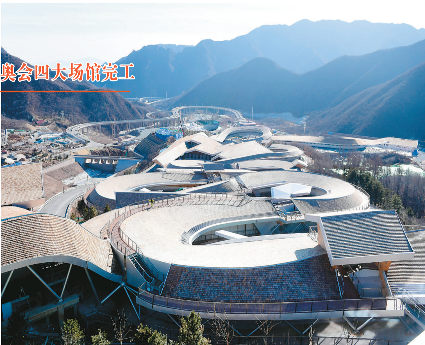
12月29日,北京2022年冬奥会延庆赛区国家高山滑雪中心、国家雪车雪橇中心、延庆冬奥村及山地新闻中心四大场馆完工。图为国家雪车雪橇中心。新华社记者张晨霖摄
