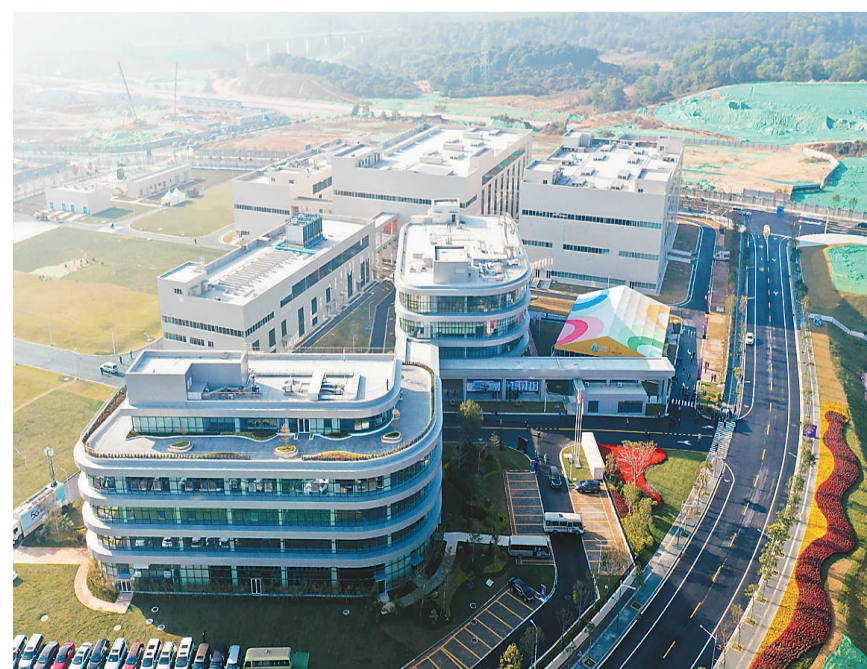
诺诚健华广州药品生产基地一期项目竣工现场。
