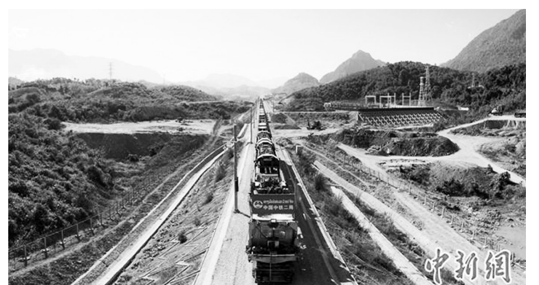
年12月15日开通运营;在建玉溪至磨憨段全长508公里,全线桥梁及路基工程基本完工,站房主体施工基本完工,93座隧道已贯通85座,全线铺轨完成25%。中老铁路建
