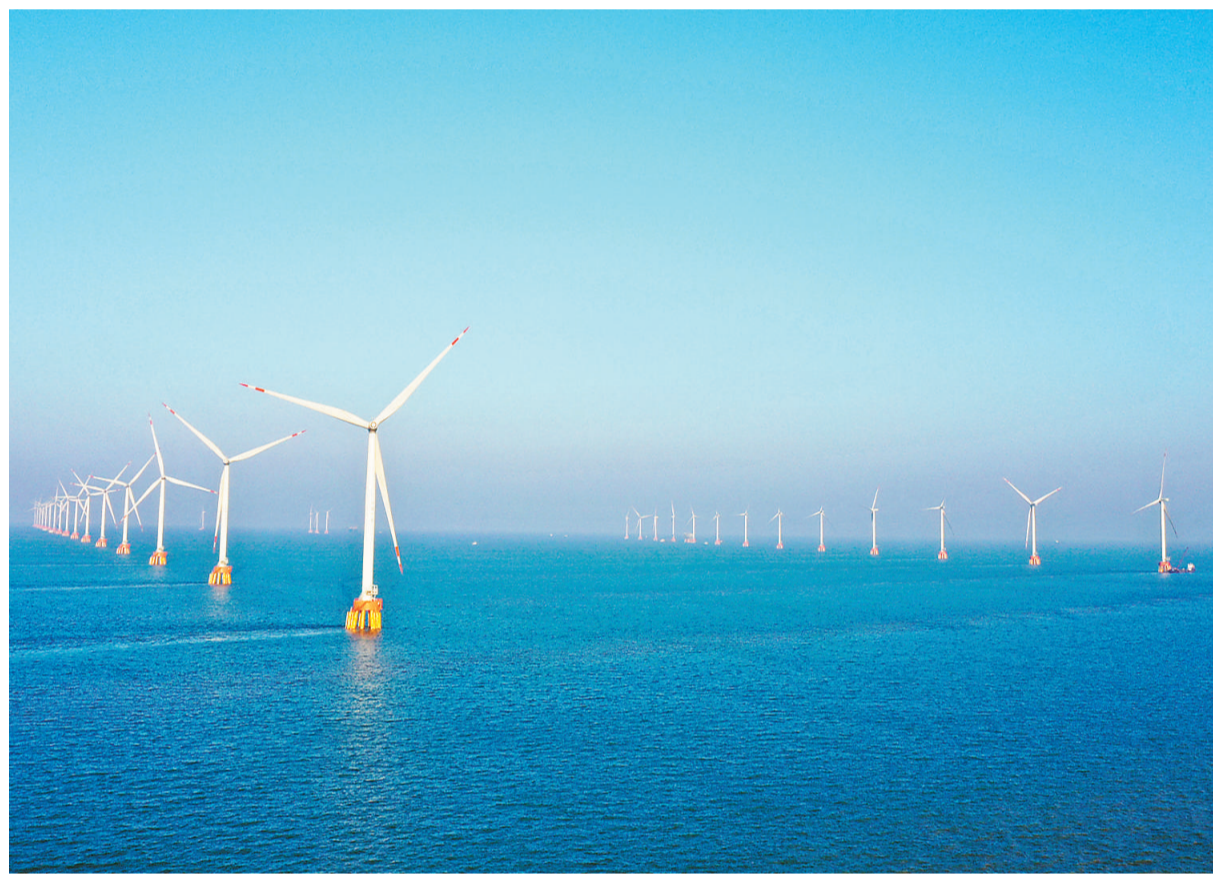
12月25日,中广核新能源浙江岱山4号23.4万千瓦海上风电项目实现54台风机电容量投产运行。据介绍,这一项目首次采用了深厚软土地质条件坐底式安装工艺,创造了风机安装平台最大插腿深度35米的纪录。该项目年上网电量达6.18亿千瓦时,可节约标煤17万吨,减少排放有害气体约47万吨,将显著改善当地的能源结构,助力生态经济发展。图为已建成的海上风机正在并网发电。
