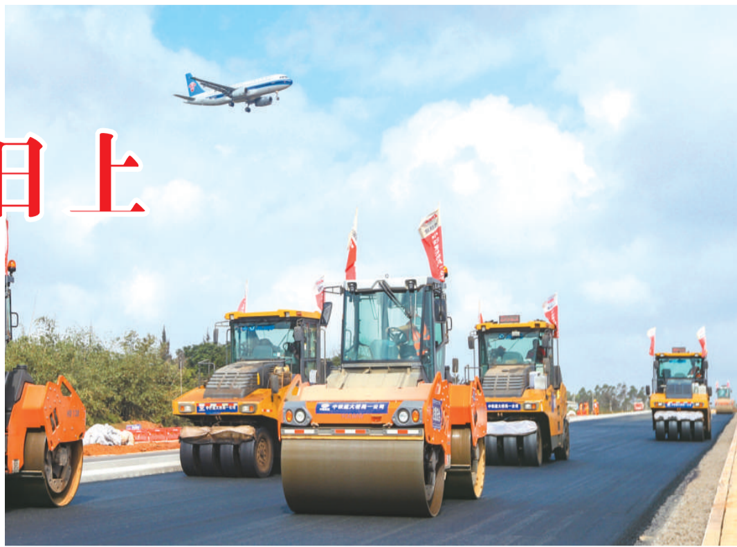
目前,海南省海口市抓住海南自贸港建设机遇,着力以综合交通枢纽为核心,分批有序推进基础设施项目,骨干路网正加速成形。图为日前在位于海口市江东新区的海口绕城公路美兰机场至演丰段施工现场,工人开着压路机铺设沥青。 王程龙摄(人民视觉)
