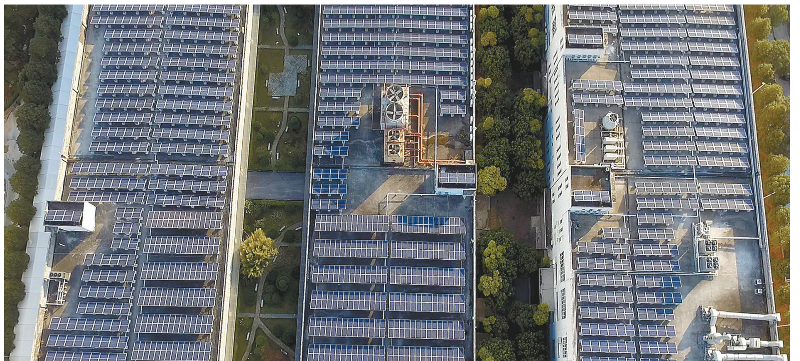
黃埔區、廣州開發區分散式光伏發電備案總裝機容量超140兆瓦。圖為阿藍爾股份有限公司屋頂分散式光伏發電項目。
