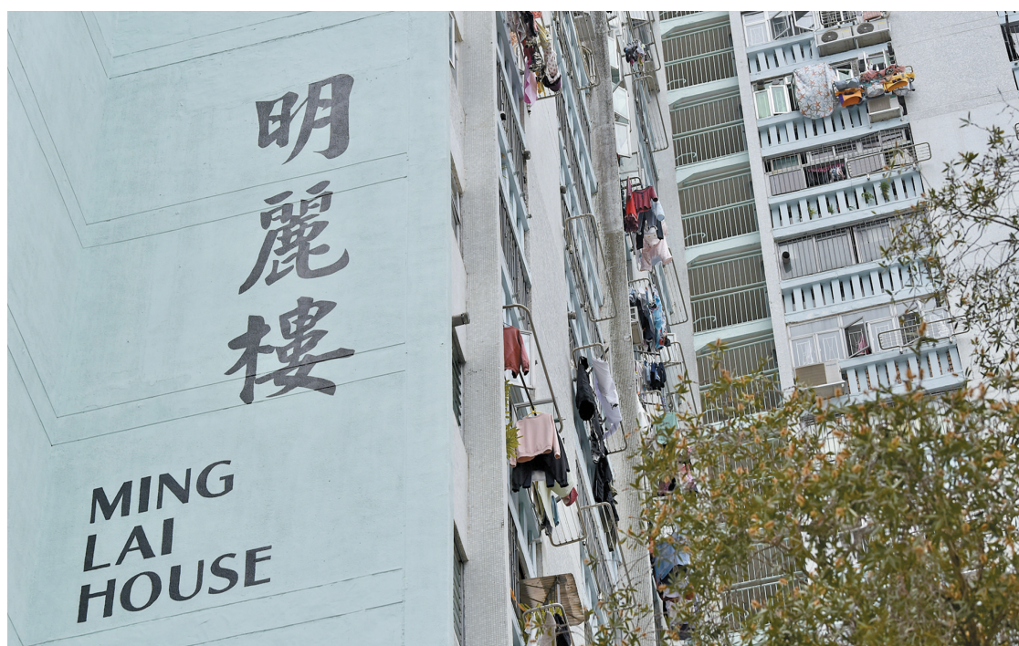
黃大仙彩雲邨明麗樓累計6人確診，疑喉管老化滲漏播疫，大廈的33及34單位居民須撤離。中新社
