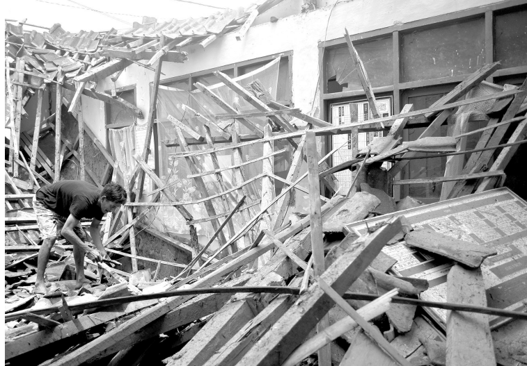
牙律县学校教室倒塌 12月15日,由于最近以来连续出现倾盆大雨,造成西爪省牙律县(Garut) Pangatikan 镇的 Bakakan Loa 2 国立小学学校的教室屋顶倒塌。
