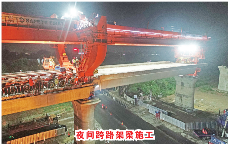
箱梁架设施工中
