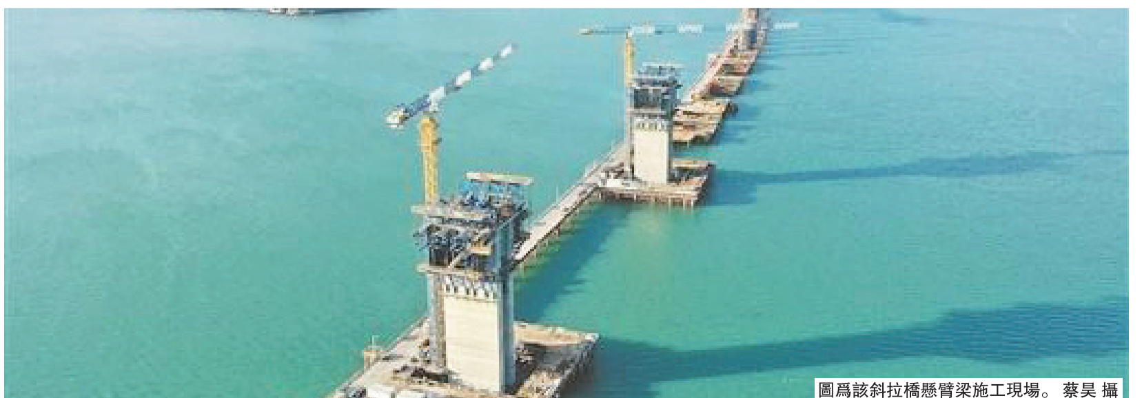
圖為該斜拉橋懸臂梁施工現場。蔡昊攝
