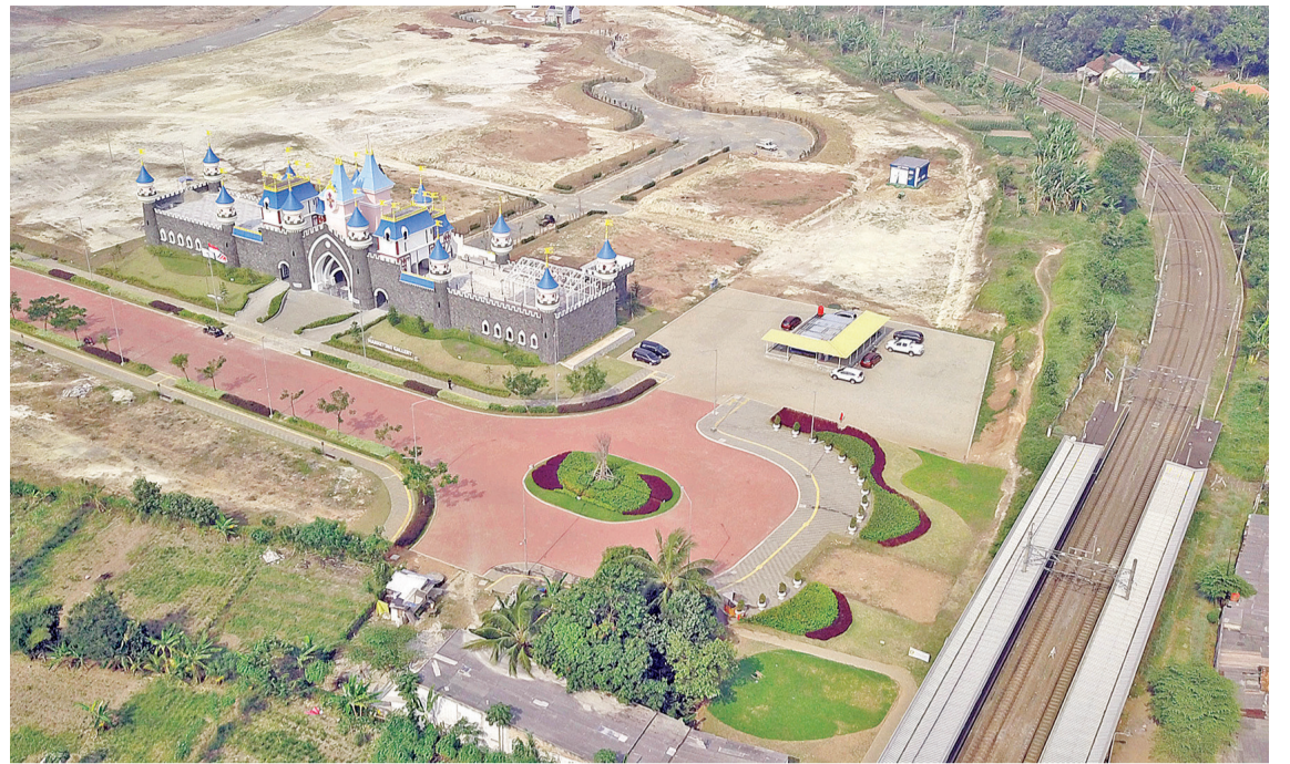
在 Modern land Cilejit 建设的车站
