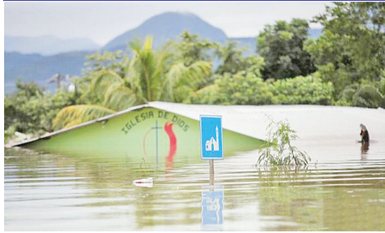
当地时间11月5日,洪都拉斯 pimenta, 飓风“埃塔”侵袭过后,当地一座建筑淹没在水中。
